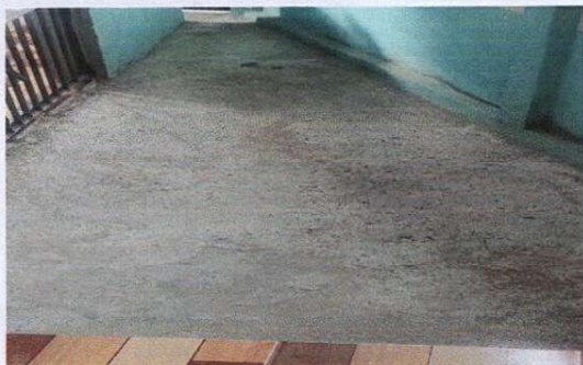
Foto 3: reparación de planchas de concreto por losa de patio
