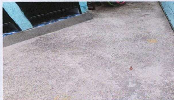
Foto 4: reparación de planchas de concreto en el área de baños
