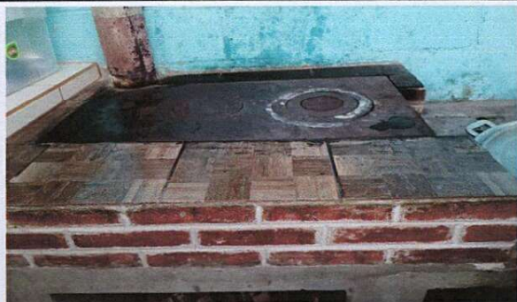
foto 5: Sustitución de plancha de metal
